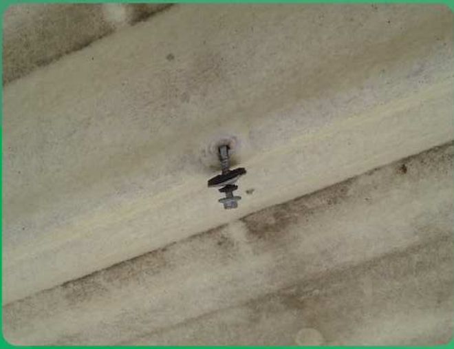
MS3 - งานบำรุงรักษา (Roof Maintenance)
